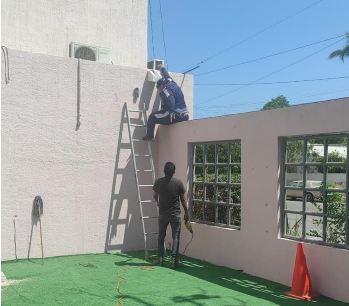
Instalación de tubería para cámaras de video vigilancia en IEEBCS
