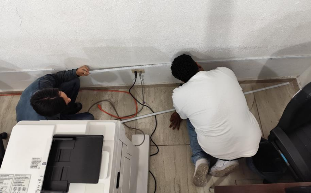
Instalación de canaleta para cableado estructurado en la oficina de la DEPPP
