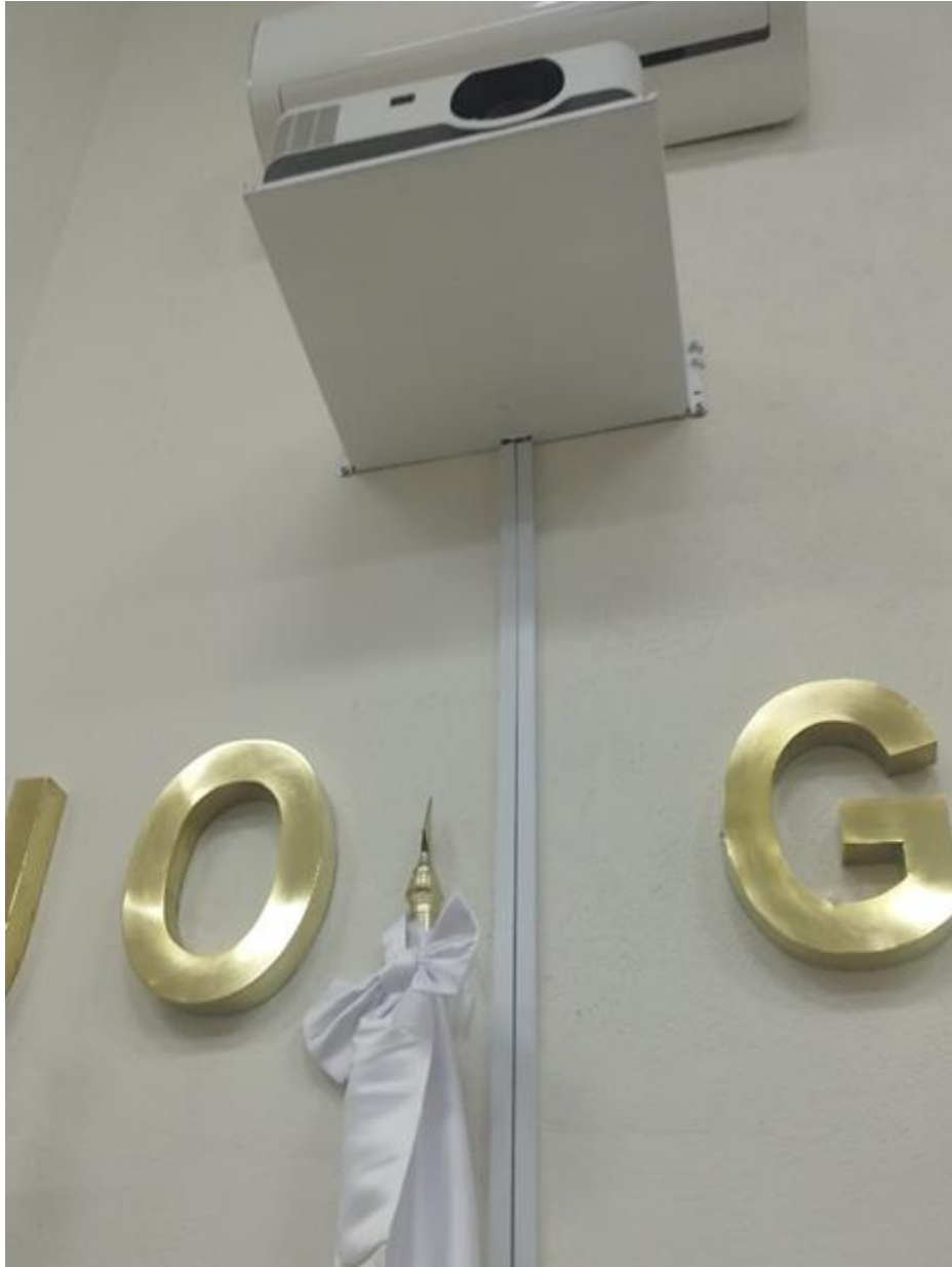
Reubicaci6n de pantalla y cableado de pared Sala de Sesiones
