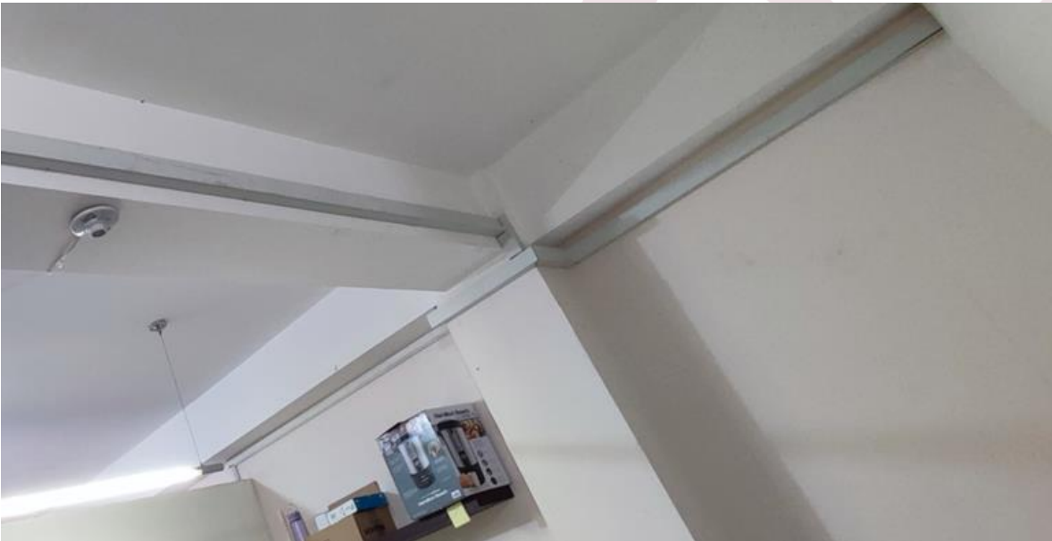
Instalación de cableado con canaleta en CCV1
