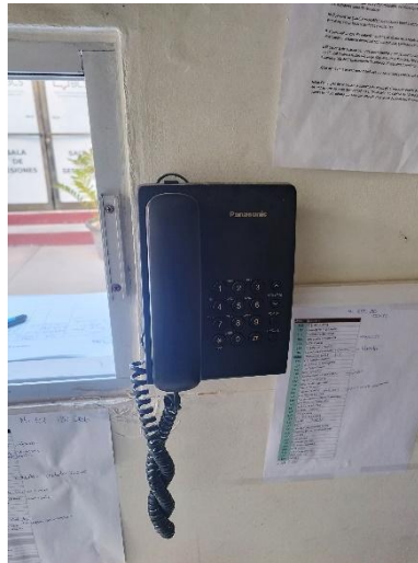
Instalación de líneas telefónicas en caseta de guardia y oficinas DEPPP
