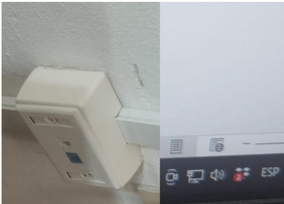
Instalación de cajas de red y pruebas de conexión
