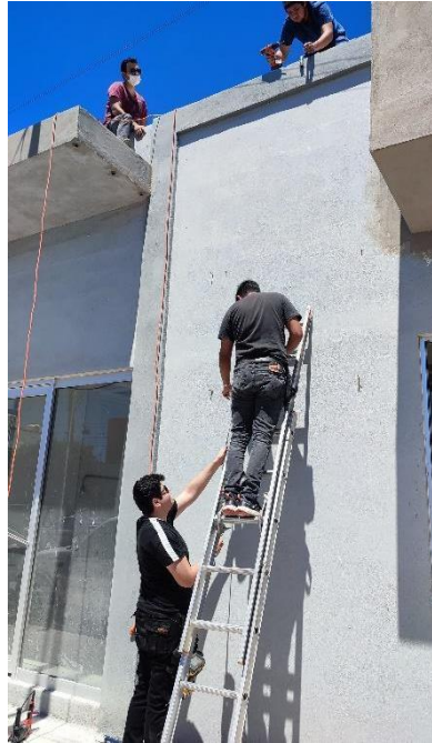
Instalación de cámaras de video vigilancia de manera permanente en las nuevas oficinas DETAISPE, DEECE y DEQDPCE
