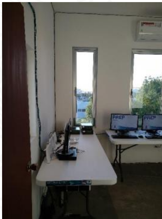
Ausencia de extintores.
